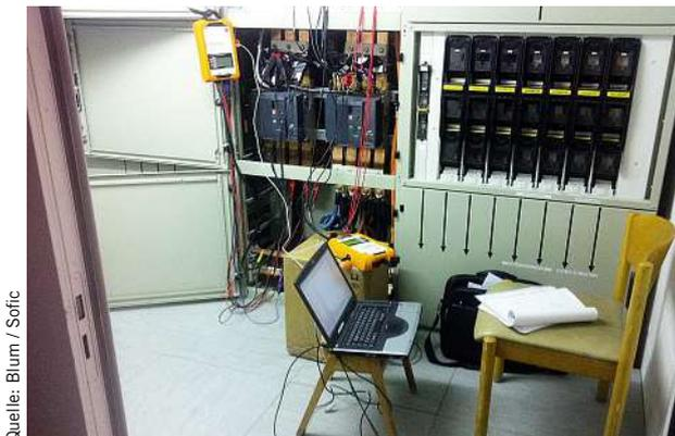
**Bild 5:** Messaufbau zur Aufzeichnung der OS-Belastungen an der NSHV-SV im Netz- und Notstrominselbetrieb
